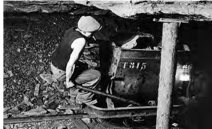
Lore (Kipptransporter auf Schienen), die im Bergwerk Käpfnach zum Transport der Kohle und des Schutts auf die Deponie gebraucht wurde. Auf der hintersten Lore eines Zugs fährt ein Bremser mit.
