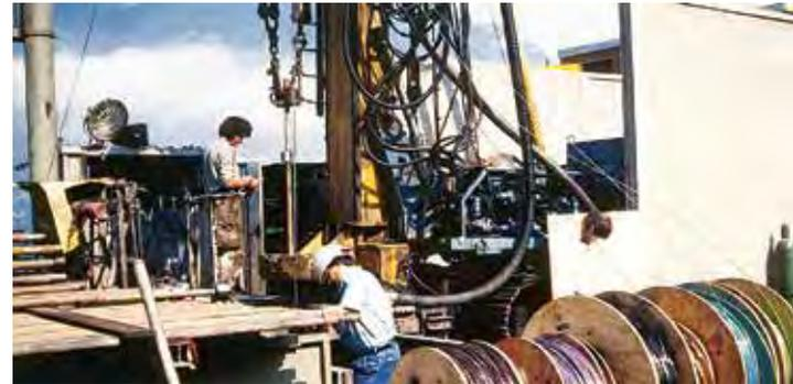
**Einbau eines Packersystems in ein Bohrloch für die Langzeitbeobachtung: Die farbigen Leitungen führen in die isolierten Bohrlochabschnitte. Foto: Nagra**
